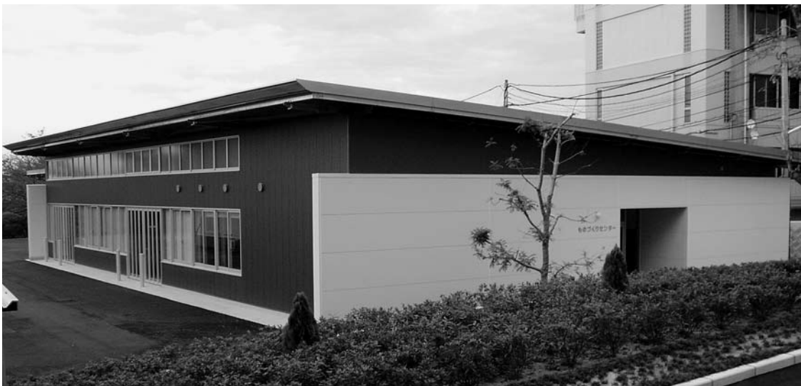
本年度新設された「ものづくりセンター」
